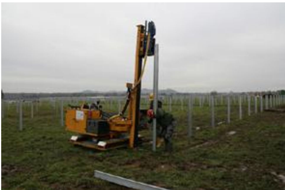
Zdjęcie 2 Montaż profili za pomocą kufara.
