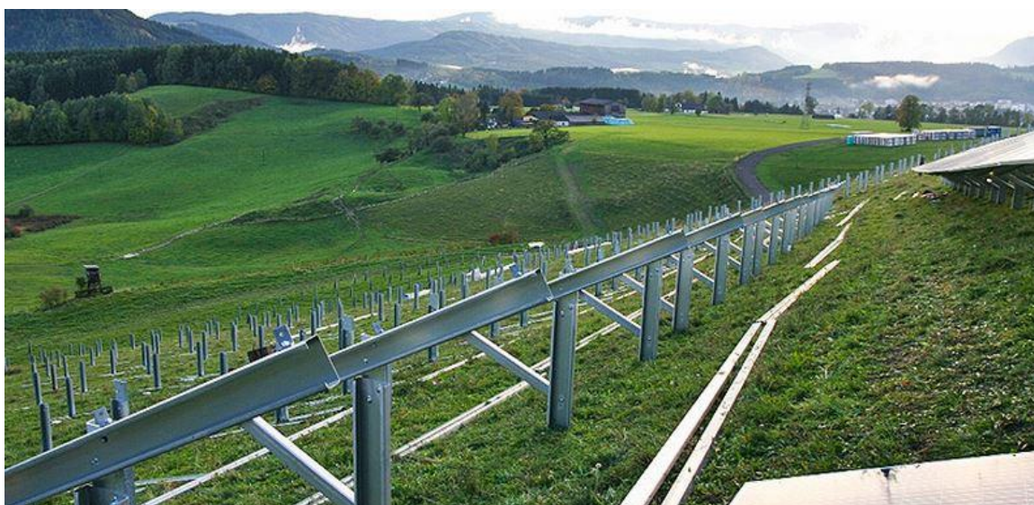
Zdjęcie 3 Konstrukcja przeznaczona do posadowienia paneli fotowoltaicznych.
